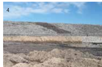
1. Perfilado de taludes, cobertura de residuos con suelo seleccionado y construcción de drenes
